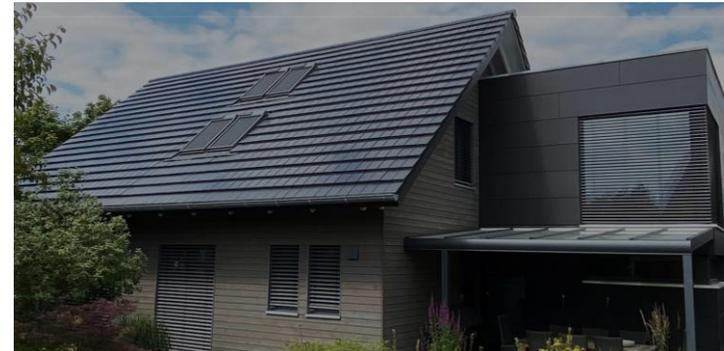
Solardachziegel am Beispiel [www.autarq.com](http://www.autarq.com)
