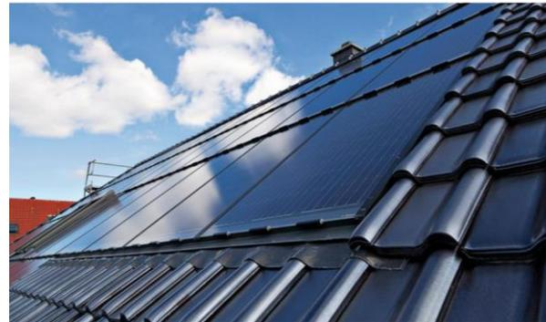
Dachintegrierte PV-Module am Beispiel von [www.solarwatt.de](http://www.solarwatt.de)
